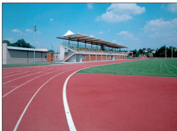
Rekonstrukce stadionu přišla na 21 milionů korun
