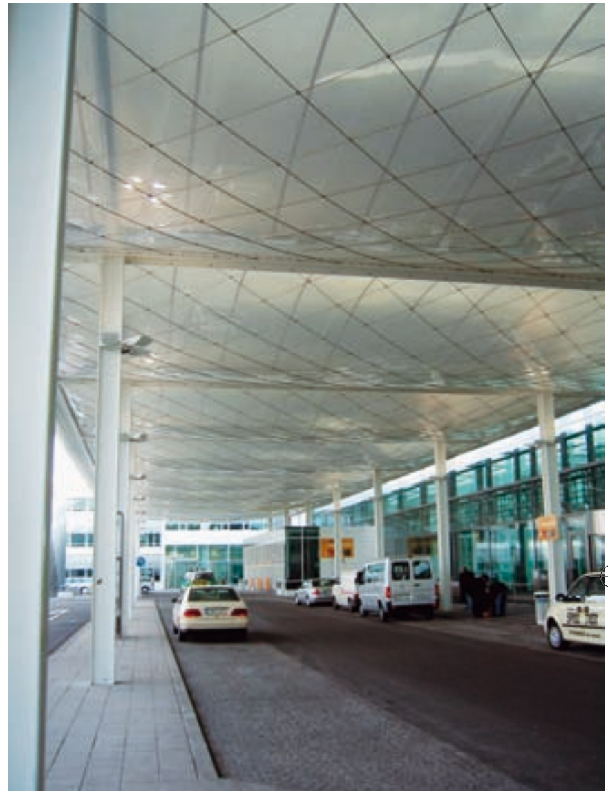
Letiště Mnichov, nafukovací polštáře v kombinaci horní membrána PTFE, dolní ETFE, podporovaná lankovou síťovinou.
