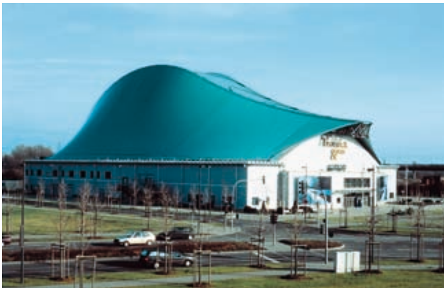
Divadlo Teatro Centro, Oberhausen (Německo) - dvouvrstvá membrána PES/PVC, typ IV s vloženou tepelnou izolací - polystyren 150mm.
