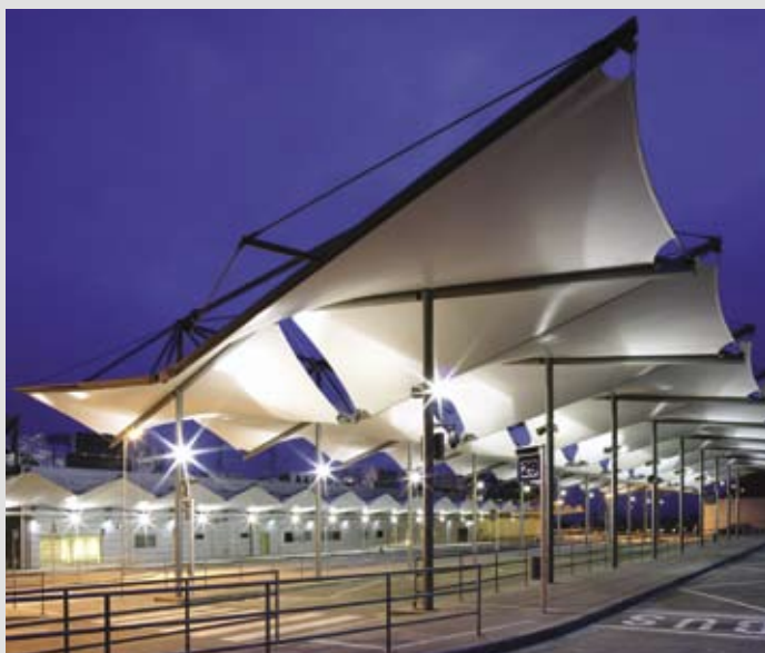
▲ Autobusové nádraží. Membránové zastřešení nástupiště.
