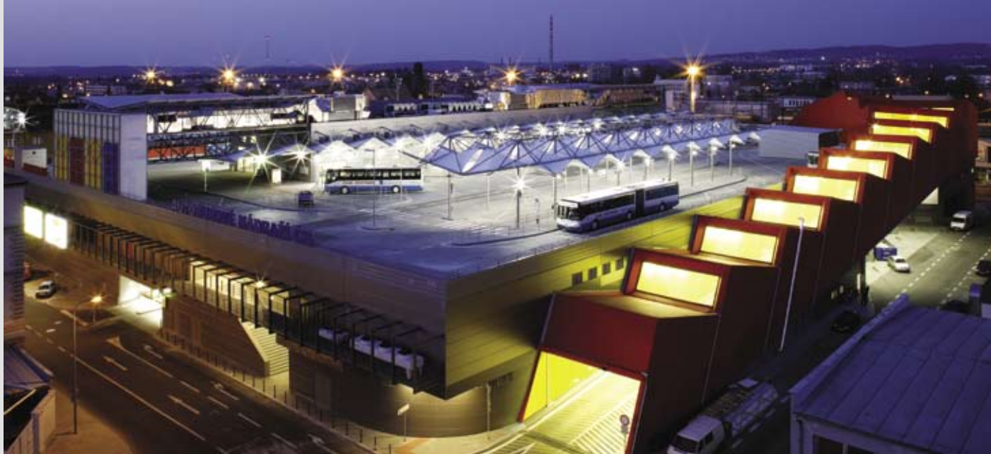
▲ Pohled na autobusové nádraží ve 3. NP stavby
