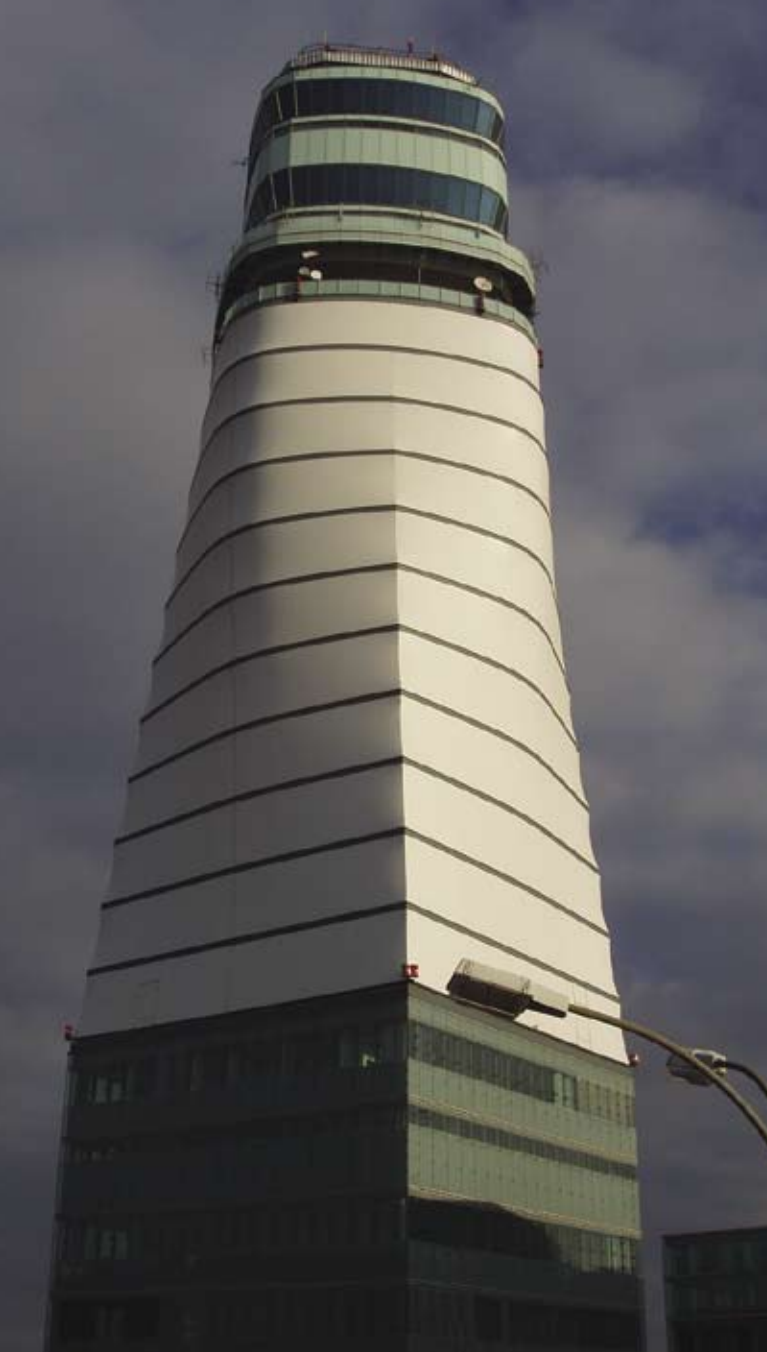
▲ Řídicí věž letiště Vídeň – pod bílou plnou textilií se ukrývá jen tenký betonový dřík řídicí věže se schodištěm a technologií
