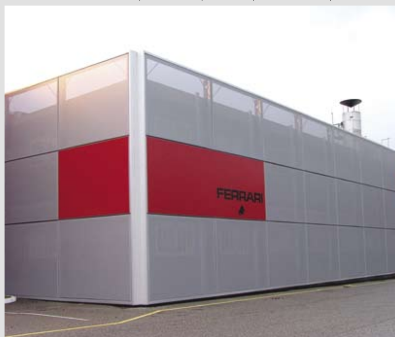
▼ Provizorní kanceláře – buňky v areálu firmy FERRARI po montáži fasády
