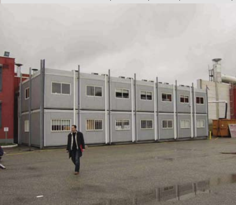
▼ Provizorní kanceláře – buňky v areálu firmy FERRARI před montáží fasády
